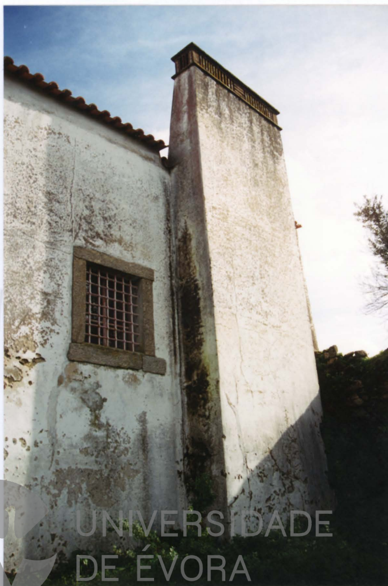
Chaminé na parte posterior do Edifício
