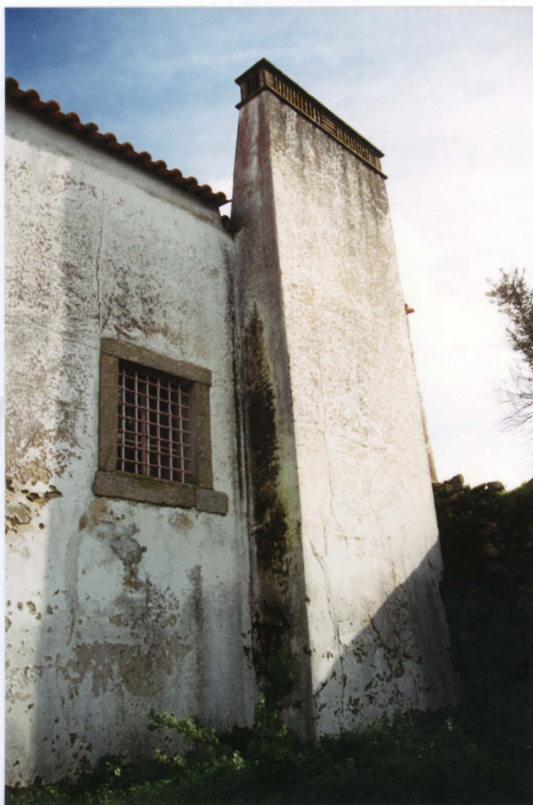
Chaminé na parte posterior do Edifício
