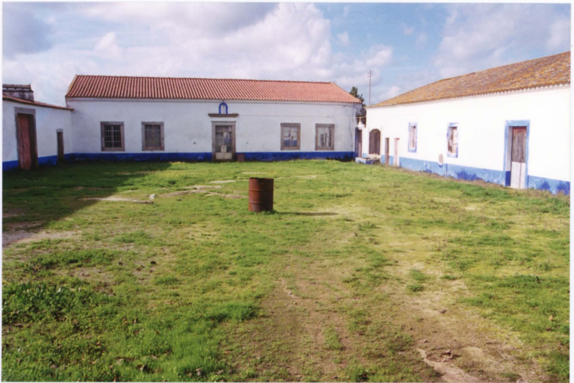
Pateo do Edifício Central
