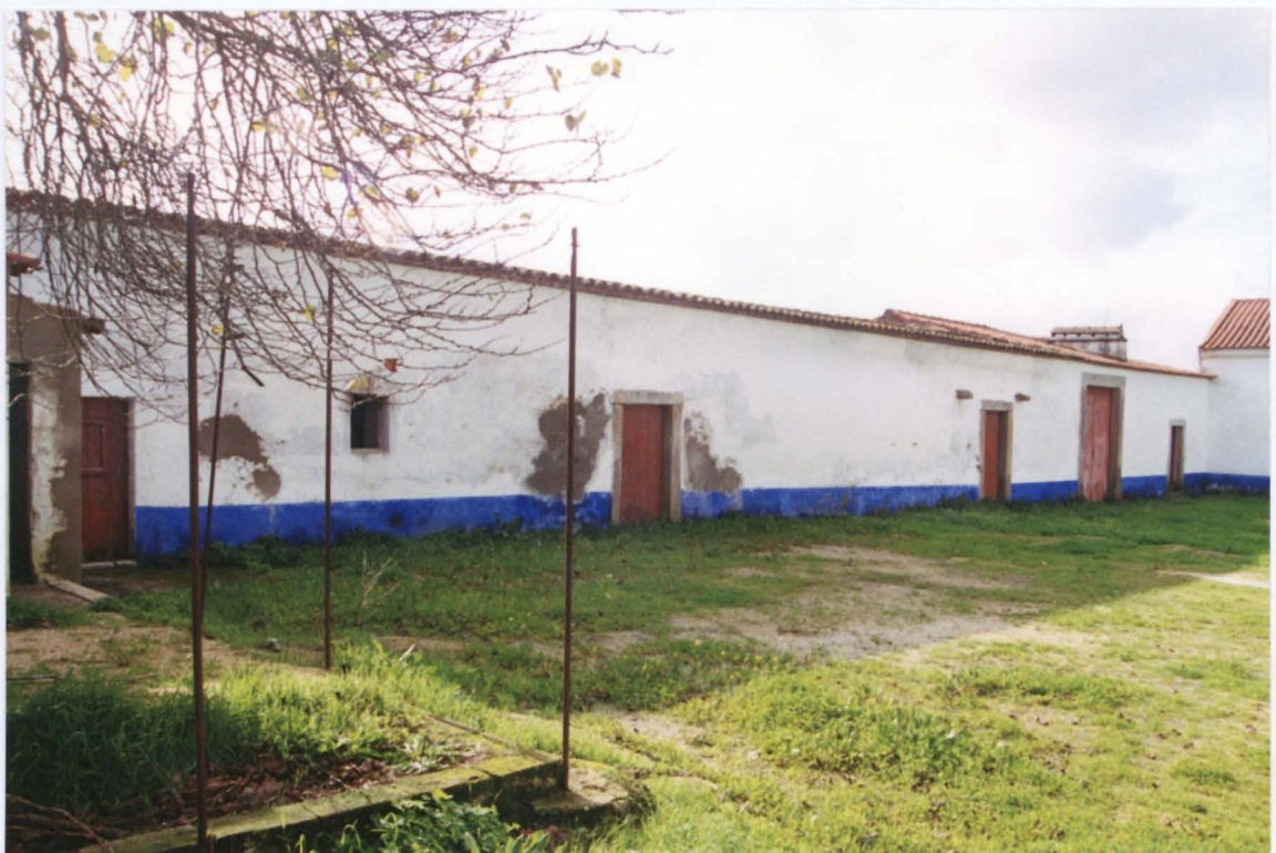
Pateo do Edifício Central
